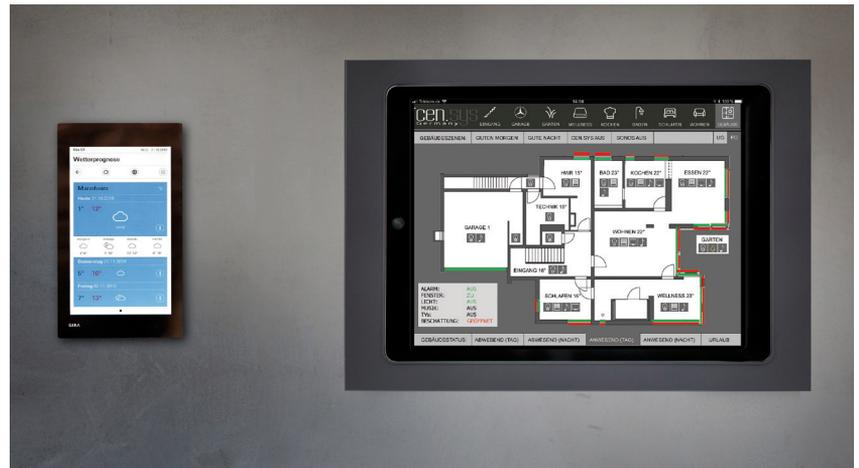
Zentrale Bedienelemente sind iPads mit der CEN.SYS Bedienoberfläche, auf denen alle Funktionen abrufbar sind, etwa über einen visualisierten Grundriss
