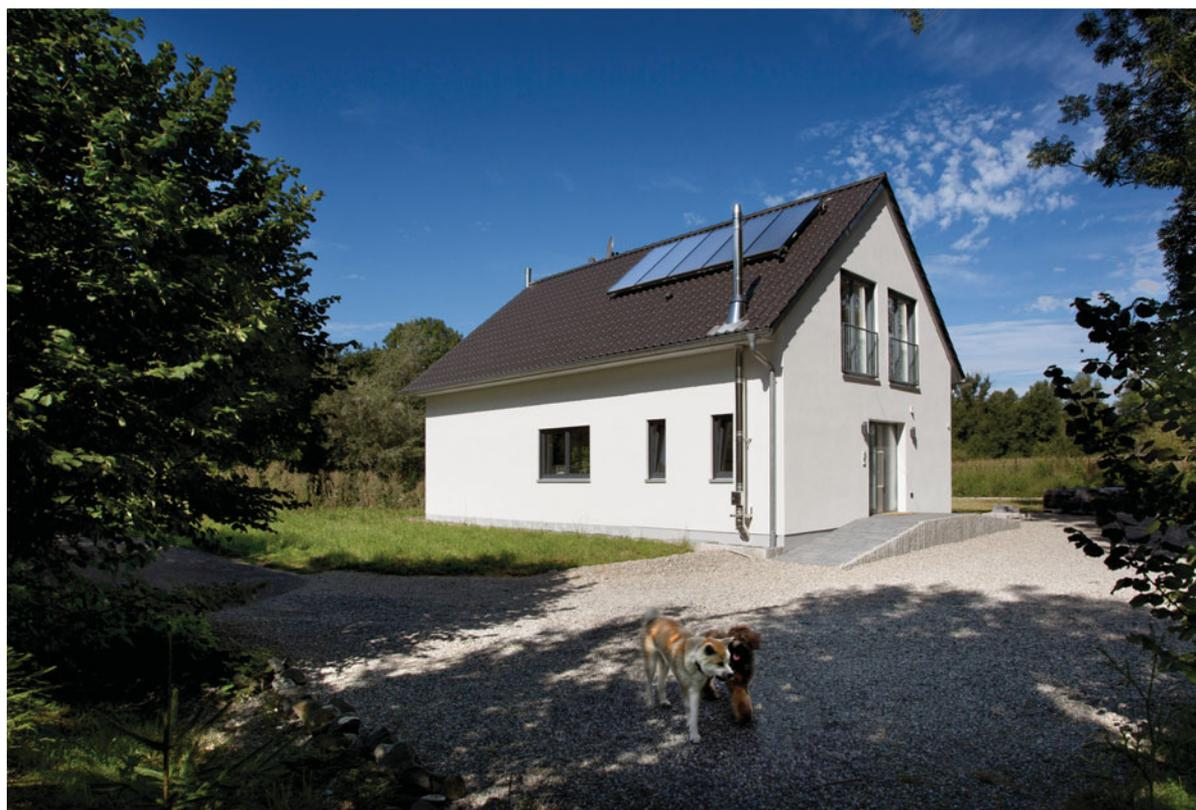
Nur wenige Außenwände des Bestands konnten erhalten werden. Diese wurden gut gedämmt und neu verputzt, der Dachstuhl und das Dach wurden komplett erneuert. Eine Solaranlage erwärmt den Pufferspeicher, der die Heizung und das Warmwasser speist
