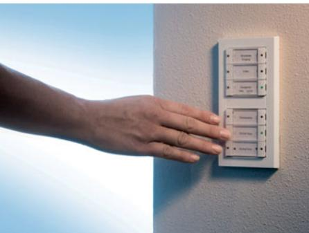
Neben der Bedienung über mobile Geräte sind im Haus Tastsensoren im Design Gira Ez Reinweiß verbaut. Auf einem dieser Taster ist die Funktion „zentral aus“ hinterlegt: Er deaktiviert das Licht im gesamten Haus sowie Steckdosen wie die vom Herd oder Backofen
