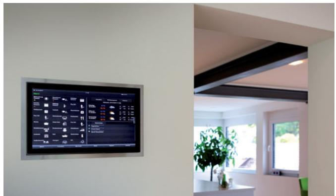
Im Zuge des Umbaus wurde ein KNX-System installiert, so dass sich alle Funktionen des Smart Homes zentral und sogar aus der Ferne steuern lassen. Steuerzentrale im Hintergrund ist ein Gira HomeServer, bedient wird über das intuitive Gira Interface beispielsweise auf einem großen Touchdisplay
