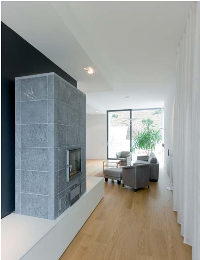
Der Kaminofen ist in die energetische Planung mit einbezogen und reicht zur Erwärmung der kompletten Etage aus
